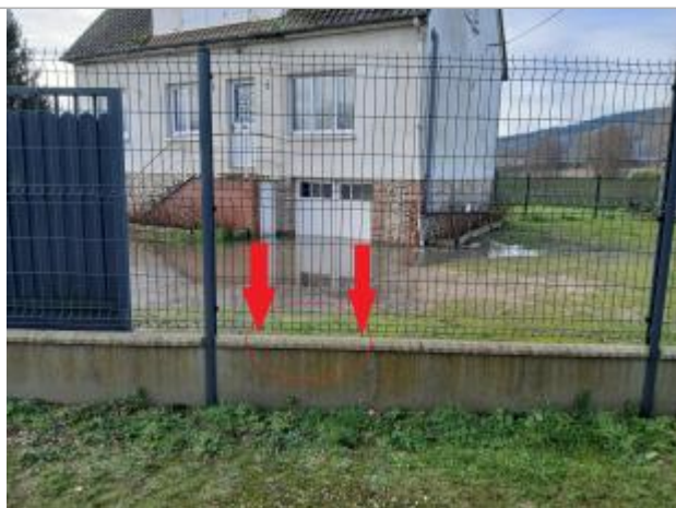
L'eau est passé au dessus du muret à 45 cm/sol
