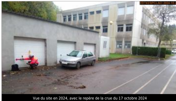
Vue du site en 2024, avec le repère de la crue du 17 octobre 2024
