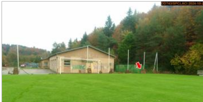
Vue du site en 2024, avec le repère de la crue du 17 octobre 2024
