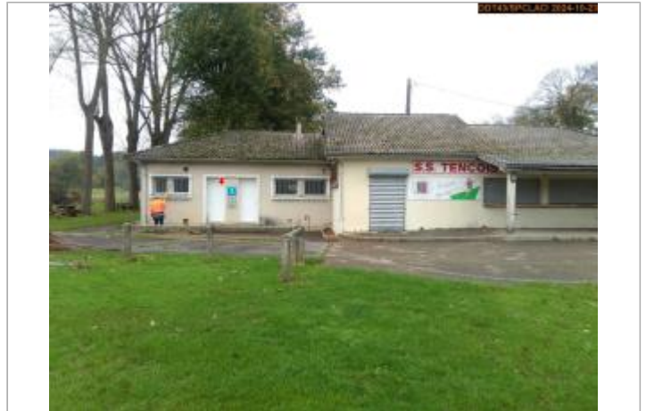
Vue du site en 2024, avec le repère de la crue du 17 octobre 2024
