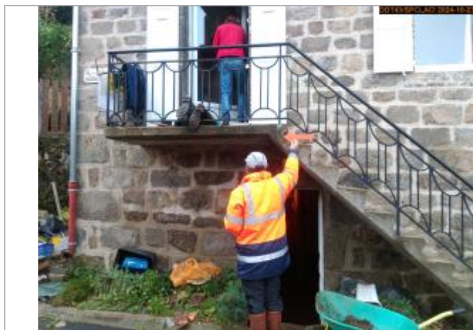
Vue rapprochée du repère en 2024
