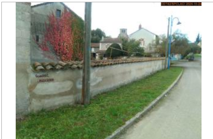
Vue du site en 2024, avec les repère de crues de 1907 et de 2008
