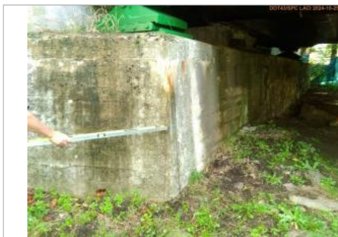
Vue du repère, en 2024
