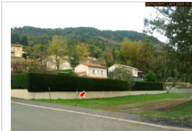
Vue du site en 2024, avec le repère de la crue du 17 octobre 2024
