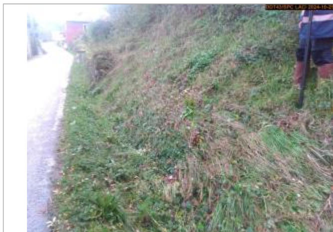
Vue du repère, en 2024
