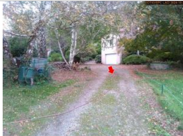
Vue du site en 2024, avec le repère de la crue du 17 octobre 2024
