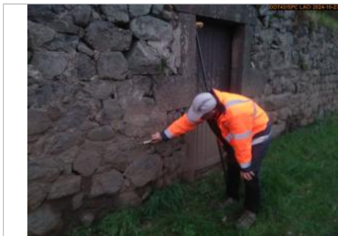
Vue du repère, en 2024
