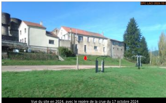
Vue du site en 2024, avec le repère de la crue du 17 octobre 2024
