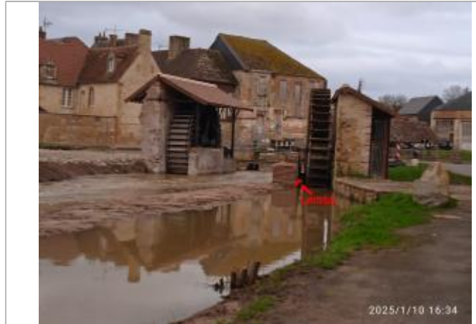
Roue du moulin en rive gauche, laisse sur le muret à l'intérieur du canal de fuite proche roue / vue aval depuis le petit chemin côté LIDL (source DDTM14)
