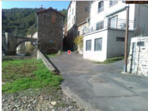
Vue du site en 2024, avec le repère de la crue d'octobre 2024
