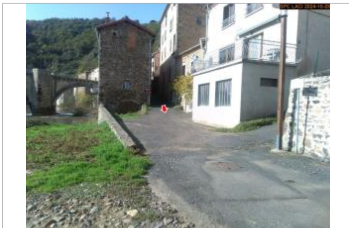
Vue du site en 2024, avec le repère de la crue d'octobre 2024
