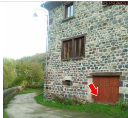
Vue du site en 2024, avec le repère de la crue d'octobre 2024
