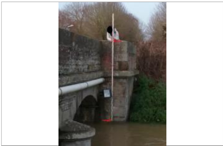
Pile de pont gauche, face aval, pont de Jort - Vue depuis la rive droite
