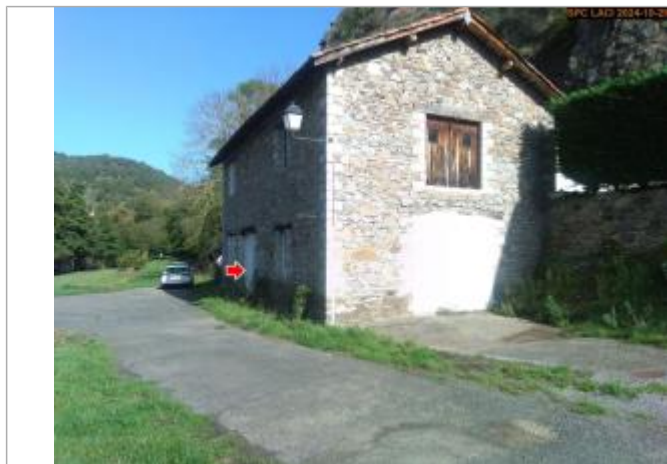
Vue éloignée du repère, en 2024
