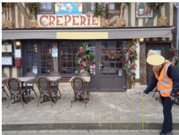
Vue lointaine repère crue façade crèperie
