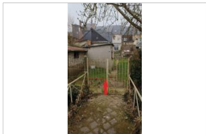
Laisse de crue à 62 cm/sol.
