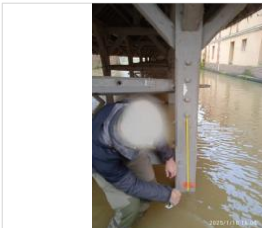
Marque peinte sur le poteau bois à 65 cm depuis le premier écrou/boulon au dessus (source DDTM14)
