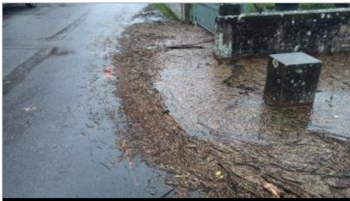
Laisse de crue au sol
