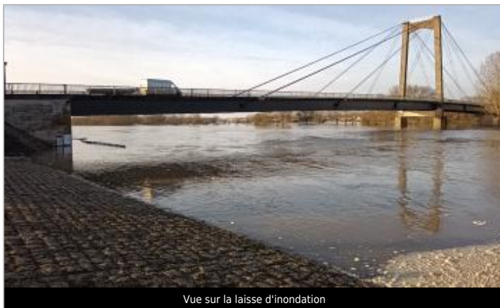
Vue sur la laisse d'inondation
