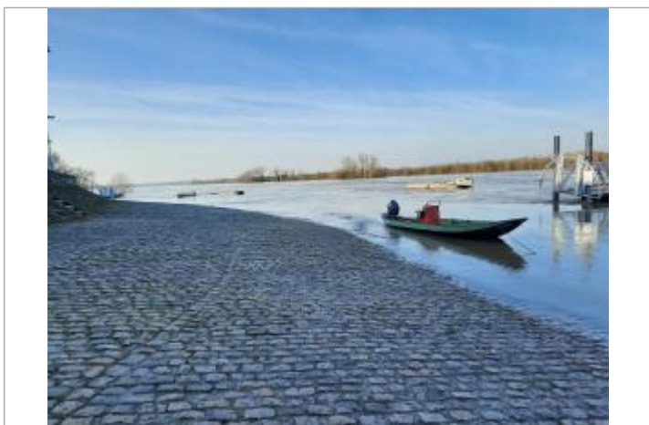
Vue sur le quai à l'aval du pont
