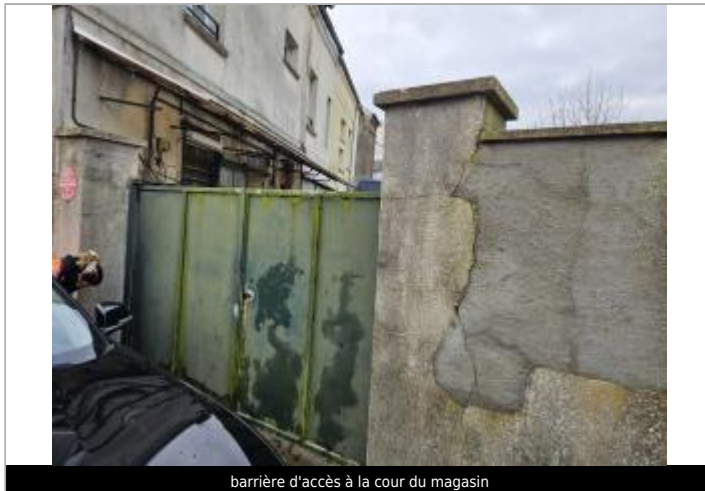
barrière d'accès à la cour du magasin
