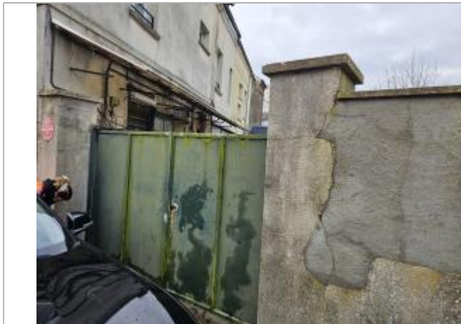
barrière d'accès à la cour du magasin
