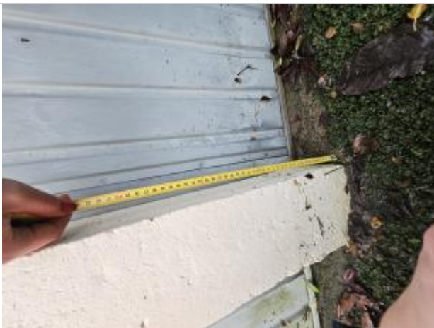
1er poteau de la 4ème porte de garage, 15 cm du sol à la marque
