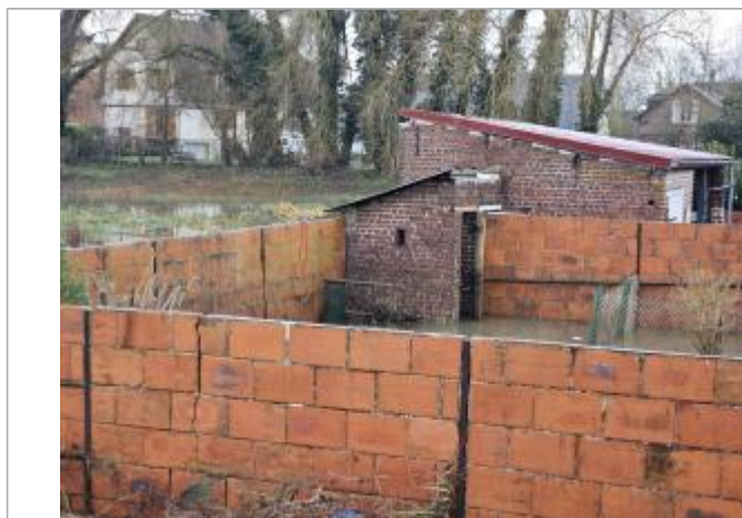
3ème brique en partant du haut du mur = marque de laisse de crue
