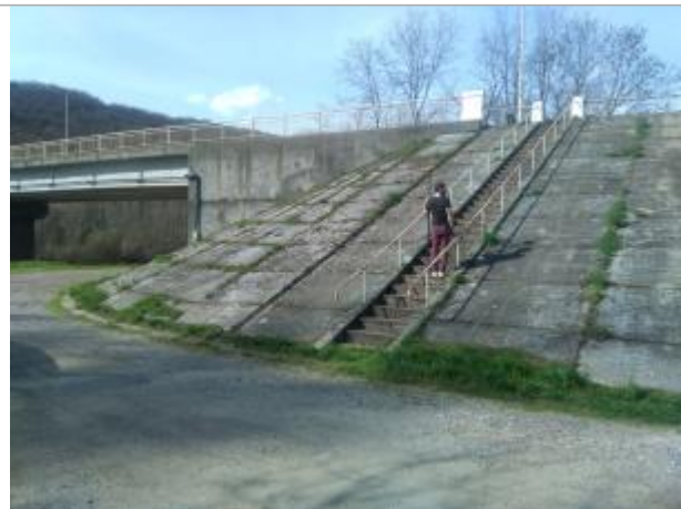
Vue du site en 2024, avec le repère de la crue de novembre 2019
