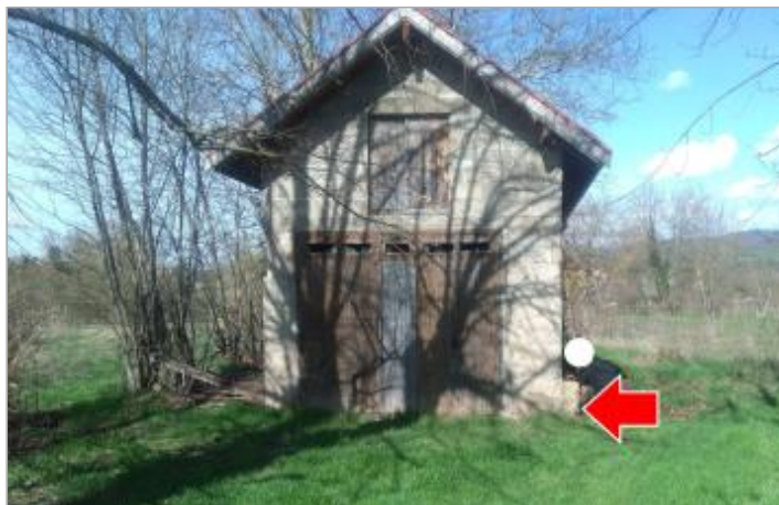
Vue du site en 2024, avec le repère de la crue de mars 2024
