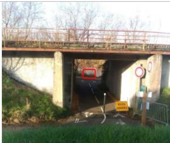
Vue du site en 2024, avec le repère de la crue de mars 2024
