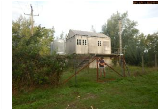
Vue du site éloignée (station pompage)
