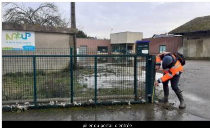
pilier du portail d'entrée
