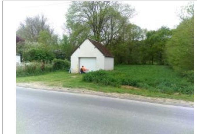
Vue du site en 2024, avec le repère de la crue de fin mars 2024
