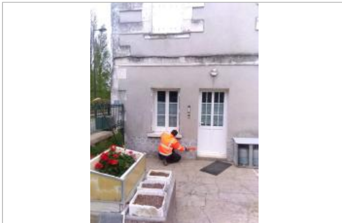
Vue du site en 2024, avec le repère de la crue de fin mars 2024
