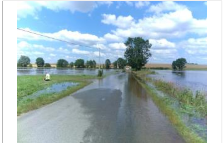
Vue du site, le 24/06/2024, SPC LACI
