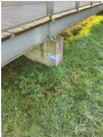
Repère fixé sur la culée de la passerelle
