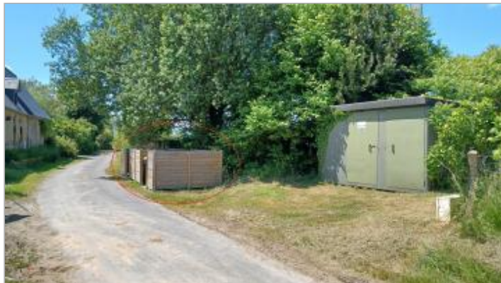
Vue depuis le chemin du Pont du Tonnerre.
