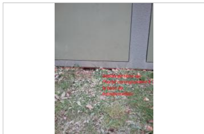
pente au droit du poste de tranformation (dépôt de sédiments sur l'herbe)
