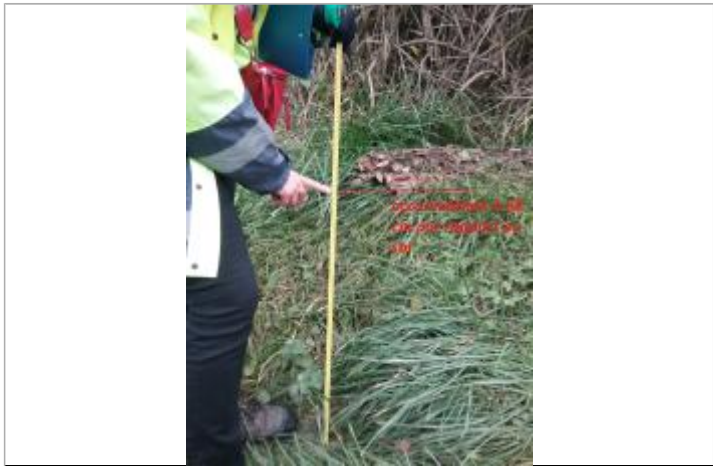
accumulation de végétaux en sommet de talus en rive droite
