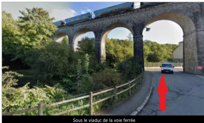
Sous le viaduc de la voie ferrée
