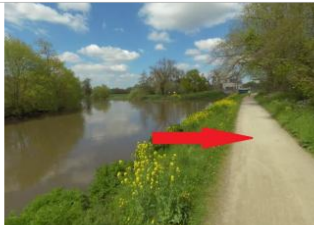
Chemin de halage en aval de l'écluse de Cicé
