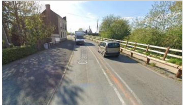
Chaussée de la RD 434 au niveau de la minoterie de Chamcorps
