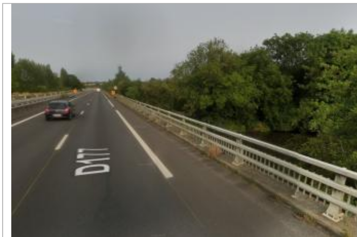
Sous le pont de la RD 177 rive droite à Goven
