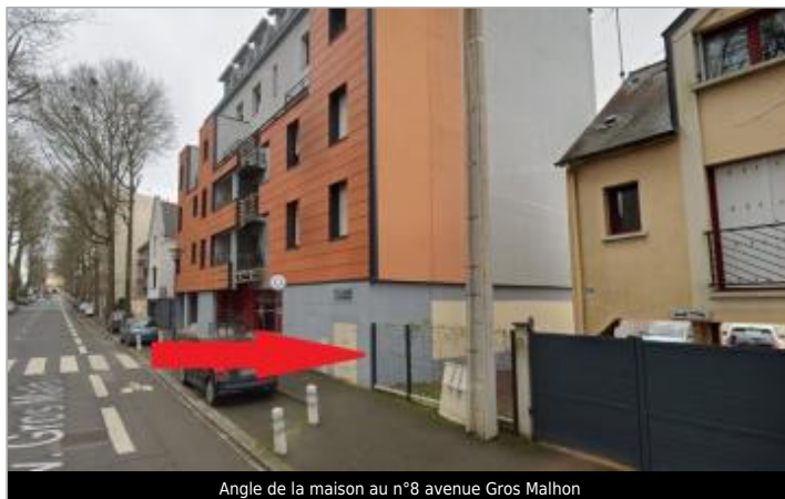
Angle de la maison au n°8 avenue Gros Malhon
