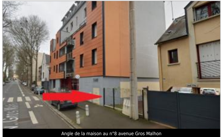
Angle de la maison au n°8 avenue Gros Malhon
