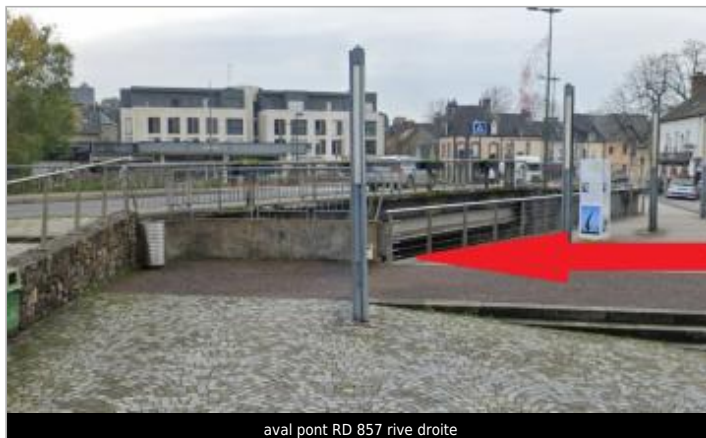
aval pont RD 857 rive droite
