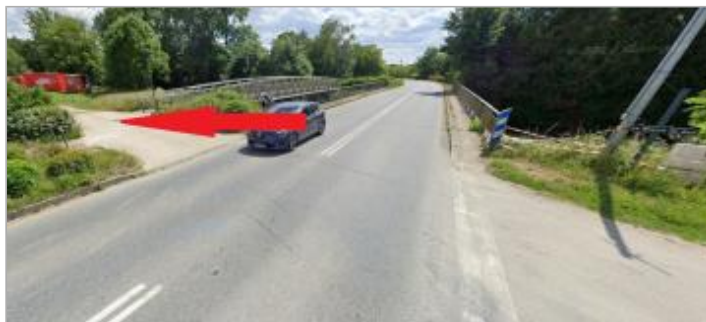
amont du Pont de la RD 101, rive gauche au moulin du Gué
