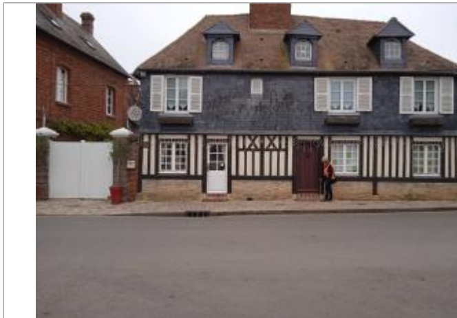
Seuil et façade de maison (source DDTM14)
