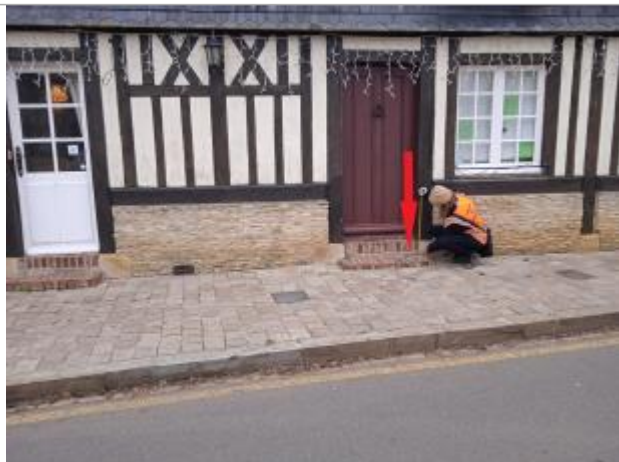
5,5 cm depuis la première marche du seuil de la maison_vue large (source DDTM 14)
