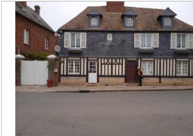
Seuil et façade de maison (source DDTM14)
