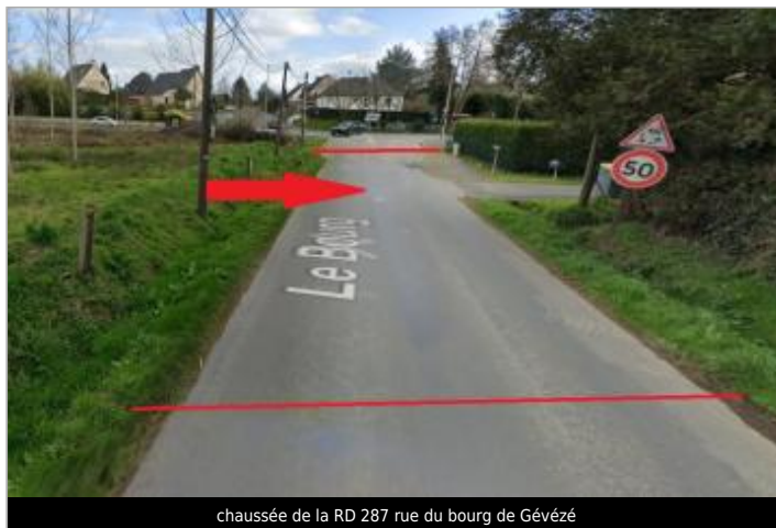
chaussée de la RD 287 rue du bourg de Gévézé
